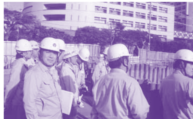
建設中の那覇市新庁舎工事を工事監査
